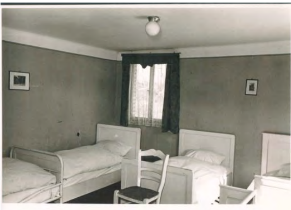
Abb. 63 Blick in einen Schlafraum
