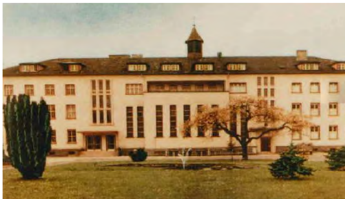
Abb. 45 Ansicht des ehemaligen Wadgasser Krankenhauses
