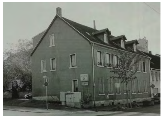
Abb. 23 Ehemaliges Säuglingsheim St. Ingbert
